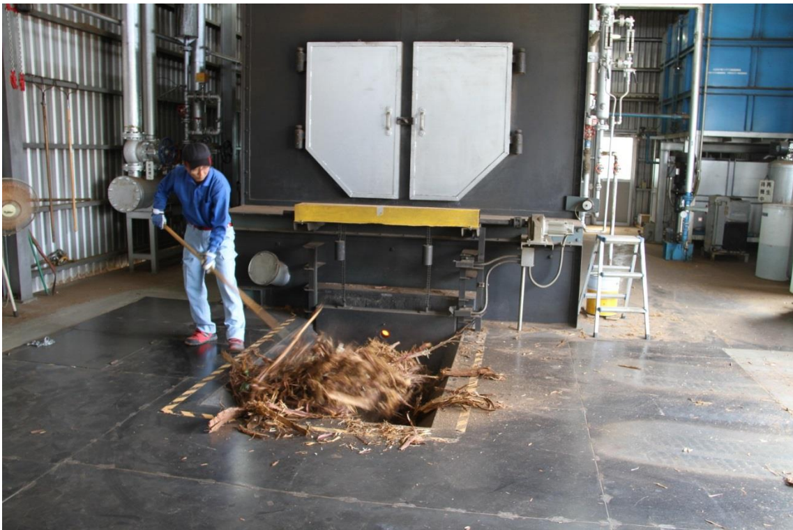
写真5 ボイラーは5人でシフトを組んで昼夜の管理
