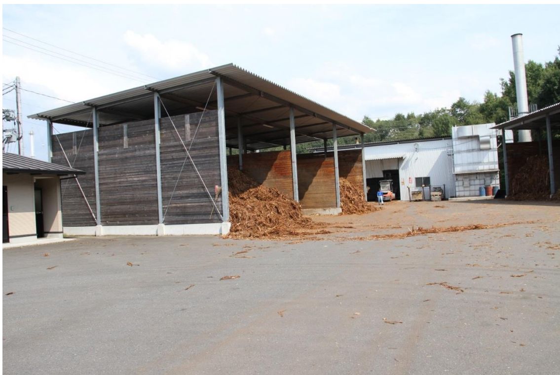
写真3 手前左が燃料ヤード、後方奥がボイラー施設
