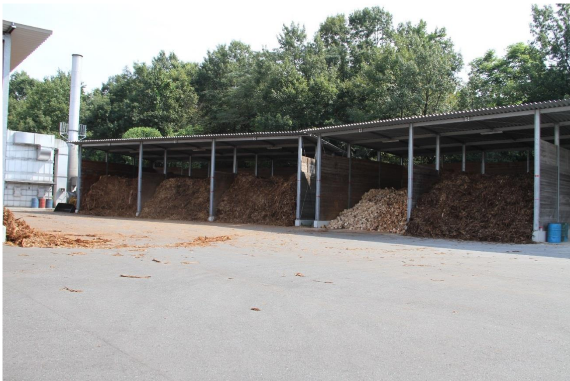
写真2 日田資源組合員から集荷したパーク（倉庫の1枠が1日分のボイラーへの投入パーク）
