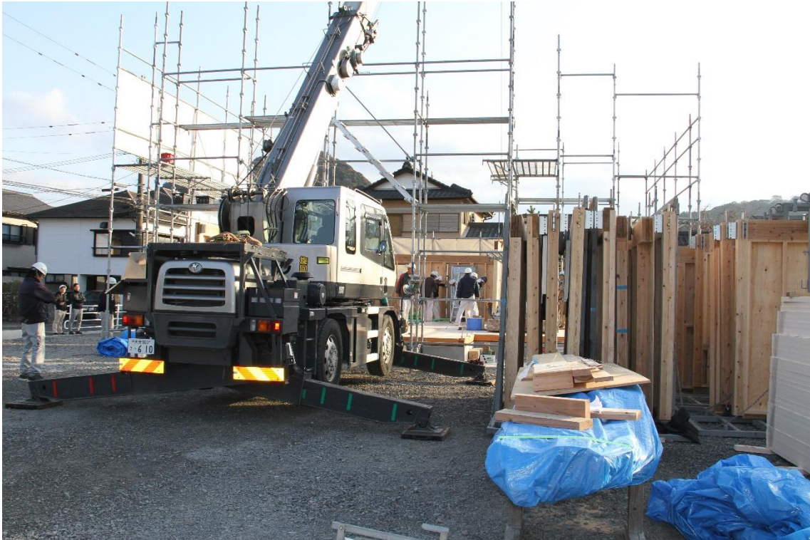
写真1 大型パネルの施工現場
