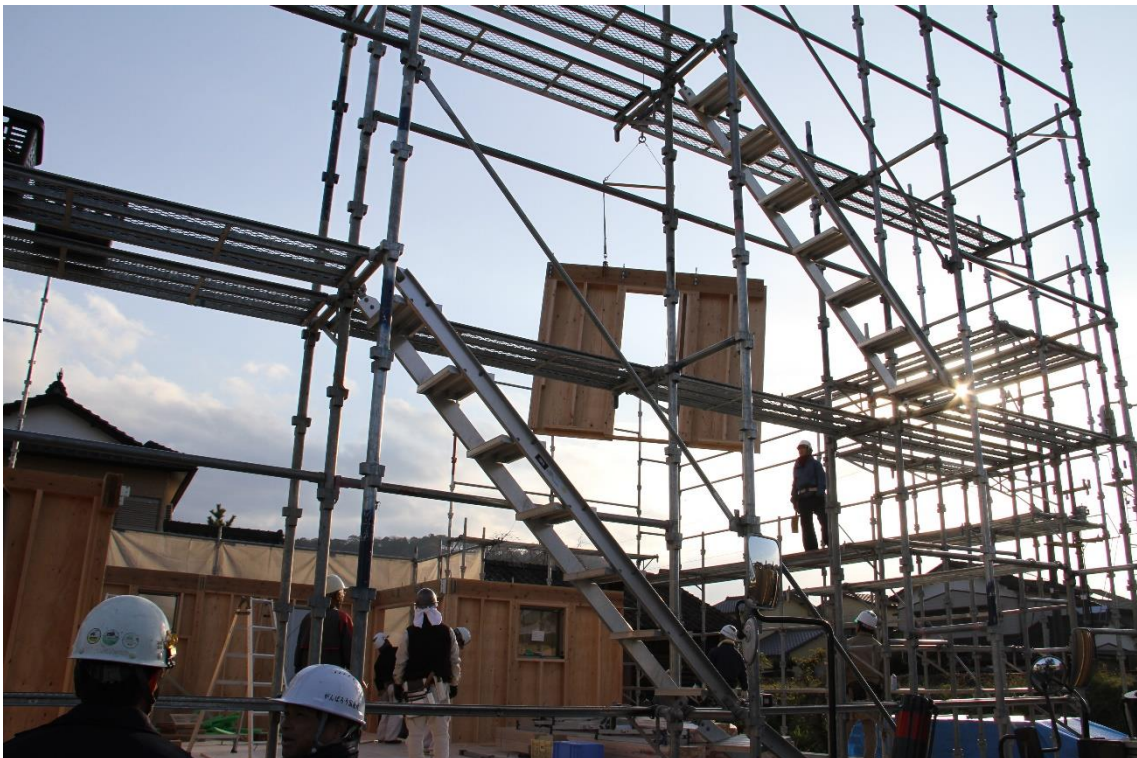
写真2 午前10時・構造材、面材、間柱、断熱材などをクレーンで住宅建築現場に投入
