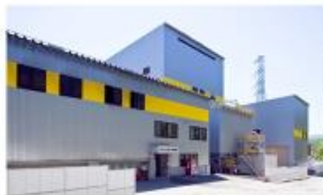
ウツミかわい区界発電所 http://w-kawai.co.jp/business/generation.html
