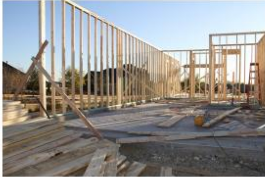
2×4住宅建築現場(ダラス市郊外)
