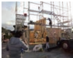
(大型パネル工法住宅上棟)
